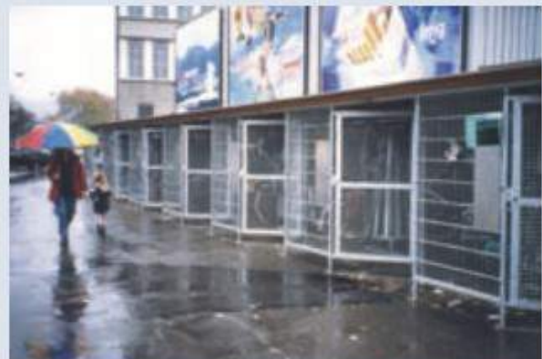
BOX PER DEPOSITO BICICLETTE (IN POSIZIONE APPESA SU PERNO ROTANTE) PRESSO UNA STAZIONE FERROVIARIA SVIZZERA
